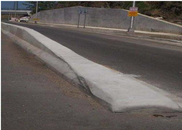
En la fotografía de la izquierda se observa que el Terminal y la barrera tienen un color que no es el adecuado. El equipo auditor debe evaluar estas condiciones, como son la capacidad de funcionar de la barrera, dimensiones, y drenajes, entre otros aspectos.
