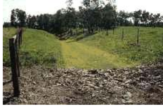
Desagüe protegido. Foto cortesía USDA-NRCS.
